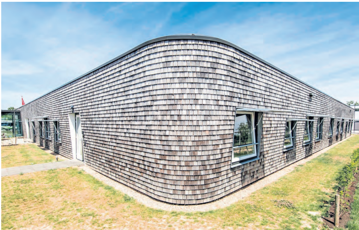
▲ Bij de bouw van de kinder- en jeugdcliniek van Emergis in Kloetinge zijn onderdelen van het gesloopte pand van Rijkswaterstaat in Terneuzen gebruikt. FOTO JOHAN VAN DER HEIJDEN
