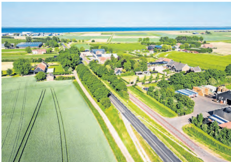
▲ Het gedeelte van de Zanddijk tussen Kruiningen en Yerseke dat op de nominatie staat voor verbreding. Als de provincie voor dit scenario kiest, zullen enkele huizen aan de noordzijde (links op de foto) moeten wijken. FOTO'S MARCELLE DAVIDSE
