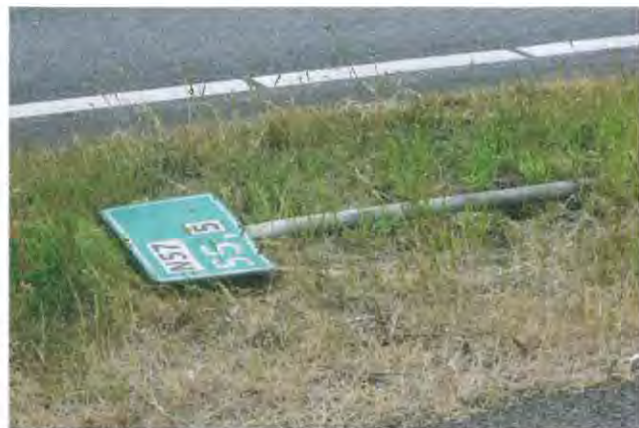
Rijkswaterstaat werkt aan de verbetering van de veiligheid van de N57
